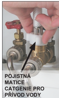
PEVNÁ MATICE NA T-ADAPTÉRU
