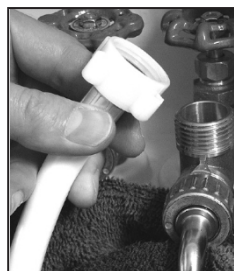
Odstraňte přívodní hadici a znovu ji připojte
